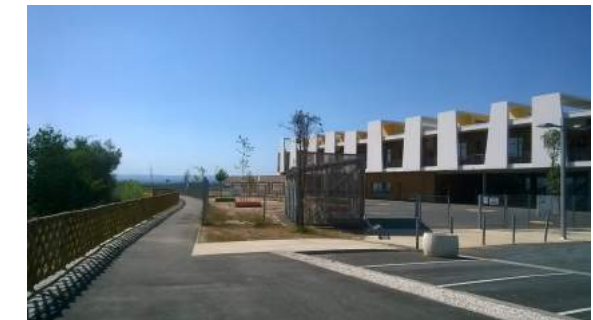
Le nouveau groupe scolaire
