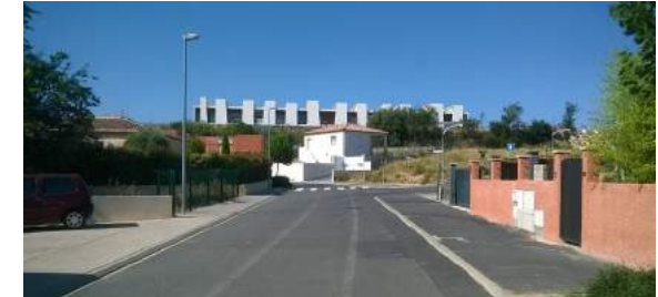
Le nouveau groupe scolaire depuis la rue Jean Moulin
